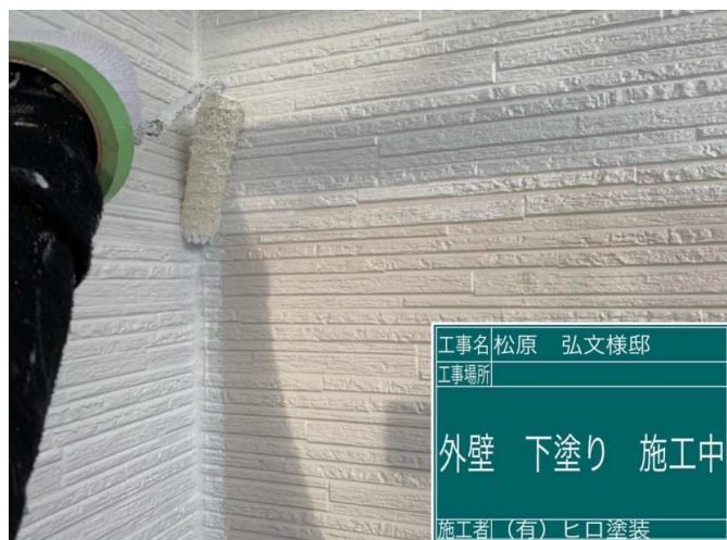
25 外壁 下塗り 施工中
