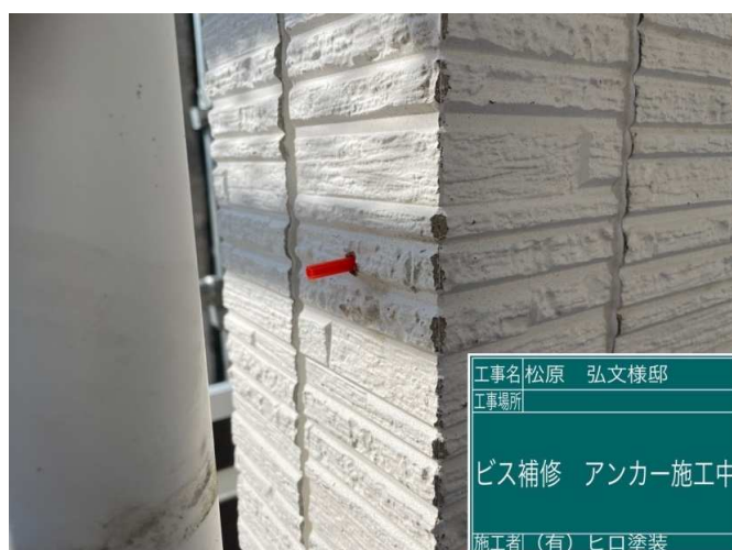
5 樋金具不良ヶ所 アンカー 施工中
