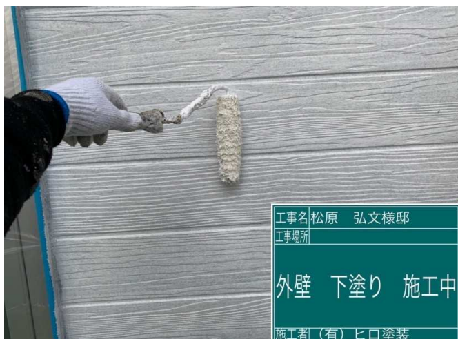
31 外壁 下塗り 施工中
