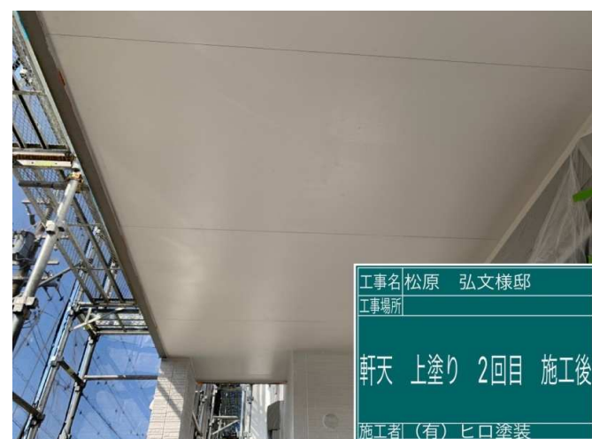
48 軒天 上塗り 2回目 施工完了
