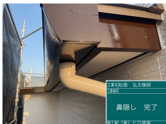
52 鼻隠し 施工完了
