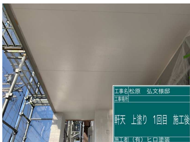
46 軒天 上塗り 1回目 施工完了
