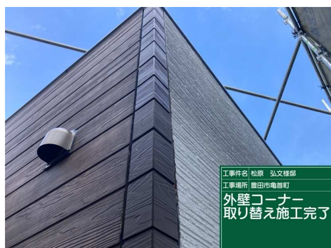
24 外壁コーナー取り替え 施工完了
