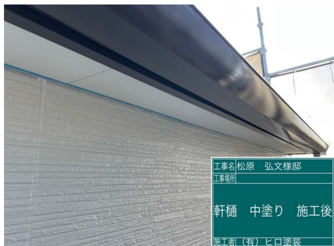
49 軒樋 中塗り 施工完了
