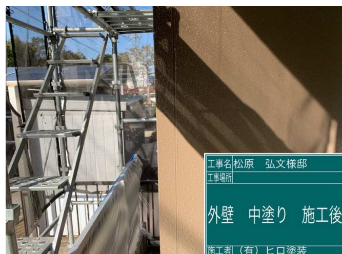
42 外壁 中塗り 施工完了
