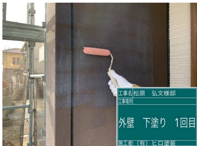
37 外壁 下塗り 1回目 施工中
