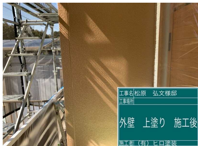
44 外壁 上塗り 施工完了
