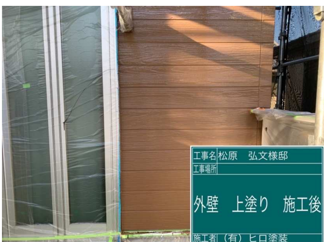
36 外壁 上塗り 施工完了
