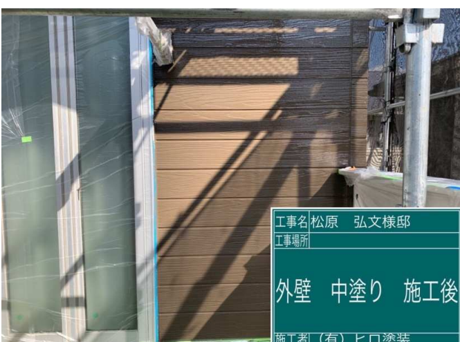
34 外壁 中塗り 施工完了
