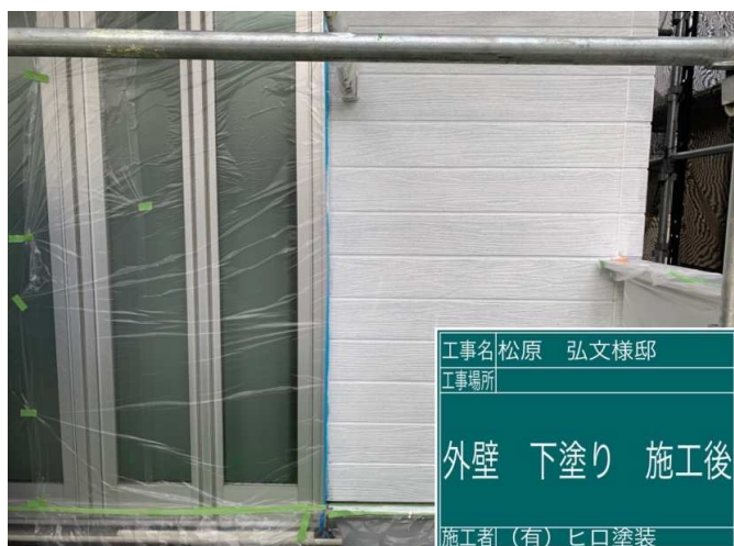
26 外壁 下塗り 施工完了
