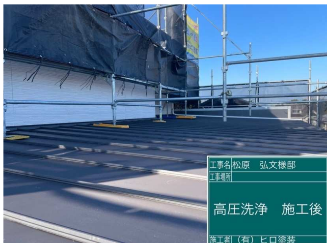
4 屋根 高圧洗浄 施工完了
