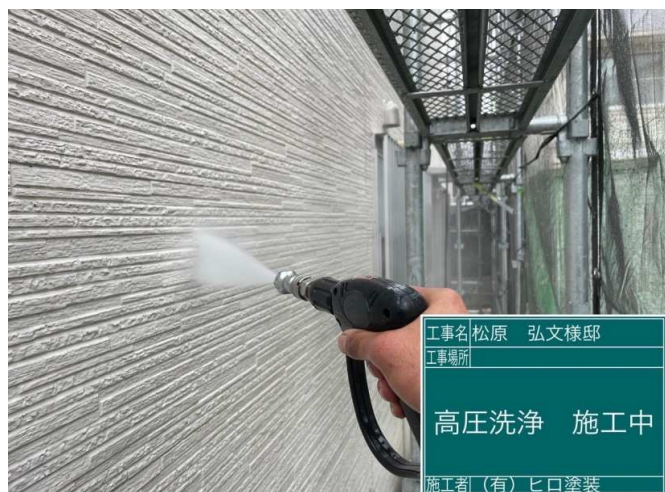
1 外壁 高圧洗浄 施工中
