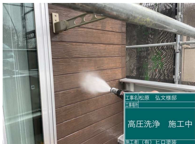
2 外壁 高圧洗浄 施工中
