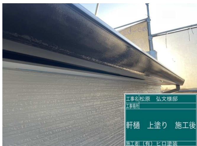
51 軒樋 上塗り 施工完了
