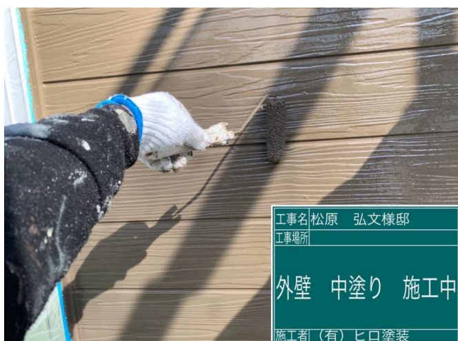
33 外壁 中塗り 施工中
