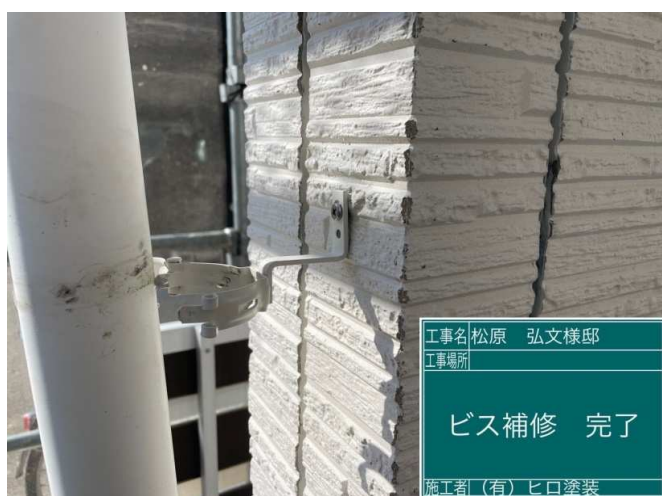
6 樋金具不良ヶ所 ビス補修 施工完了
