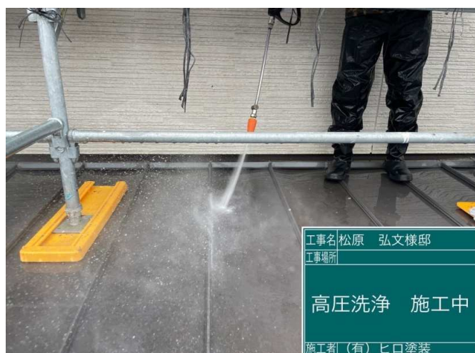
3 屋根 高圧洗浄 施工中
