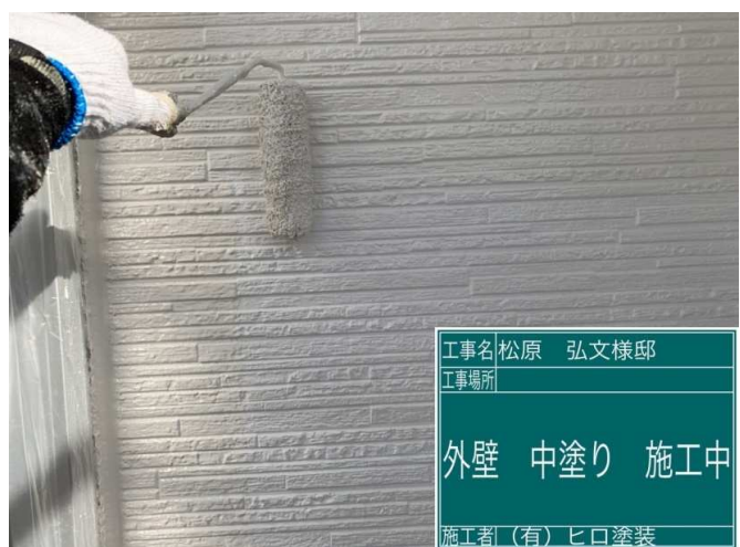
27 外壁 中塗り 施工中
