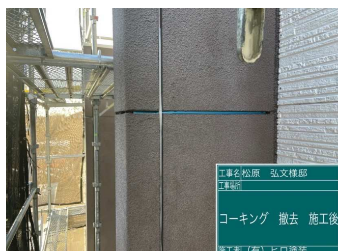
12 コーキング 撤去 施工完了
