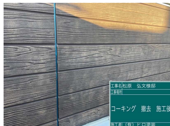
10 コーキング 撤去 施工完了
