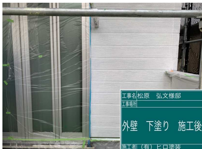
32 外壁 下塗り 施工完了
