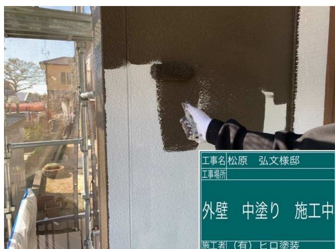
41 外壁 中塗り 施工中
