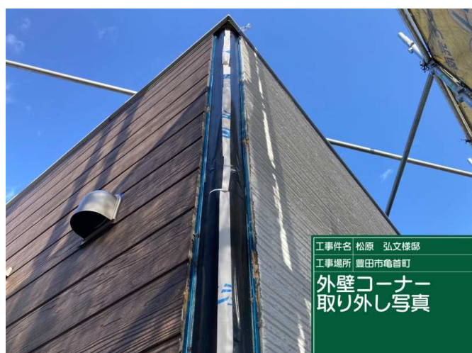
23 外壁コーナー撤去 施工完了
