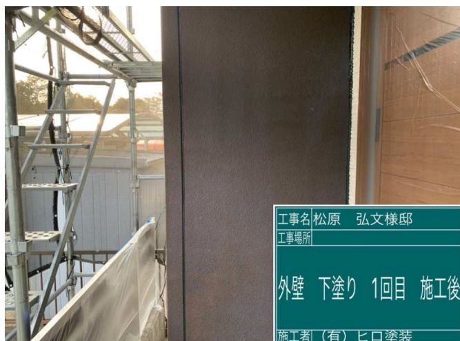
38 外壁 下塗り 1回目 施工完了
