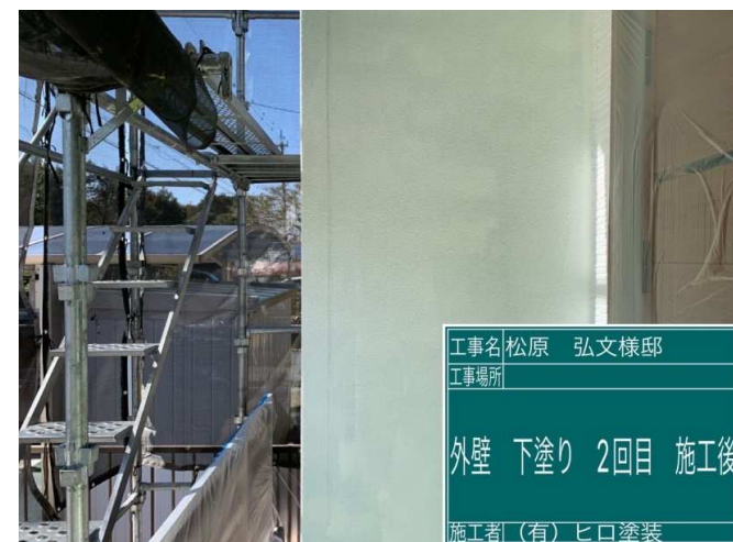
40 外壁 下塗り 2回目 施工完了
