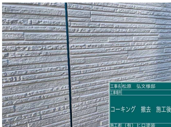
8 コーキング 撤去 施工完了
