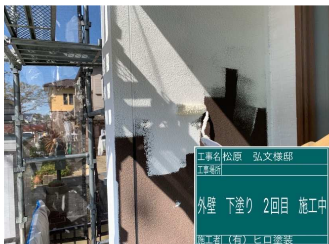
39 外壁 下塗り 2回目 施工中
